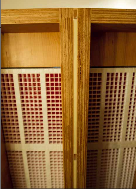
Die Zwischenräume der Stützstreben sind mit einer keramischen Vergussmasse verfüllt
